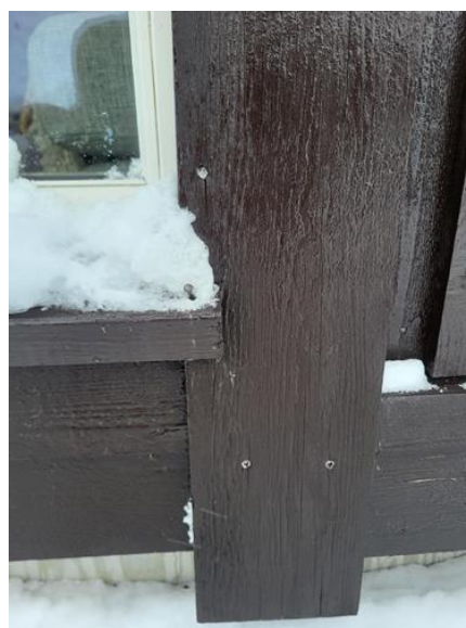
Utvendig - [Delaj vindu]
