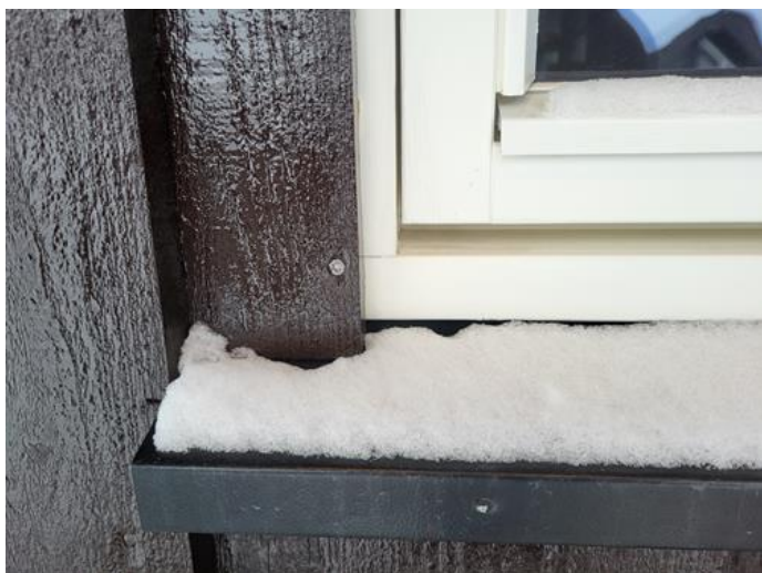
Utvendig - [Detalj vindu]
