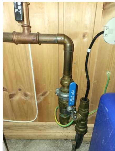
Tekniske anlegg, VVS anlegg (Sjekkpunkter utover det som er inkludert i andre rom) - [Hovestoppekran]
