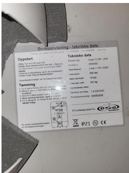
Tekniske anlegg, VVS anlegg (Sjekkpunkter utover det som er inkludert i andre rom) - [Info VVB]
